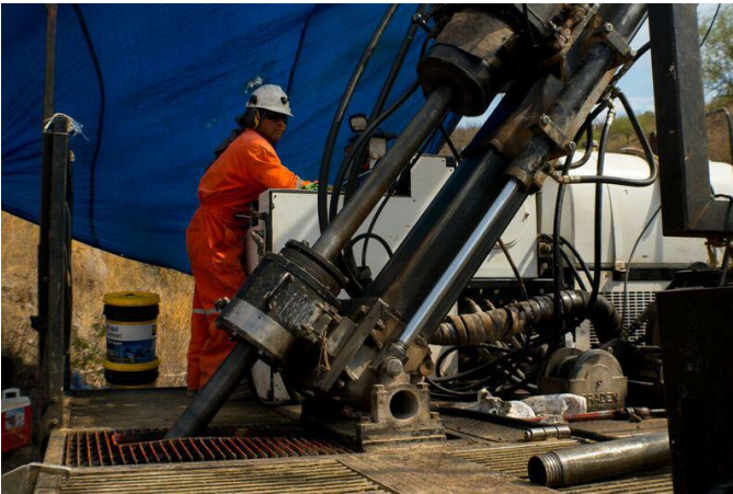
Figura 4. Proceso de perforación.
