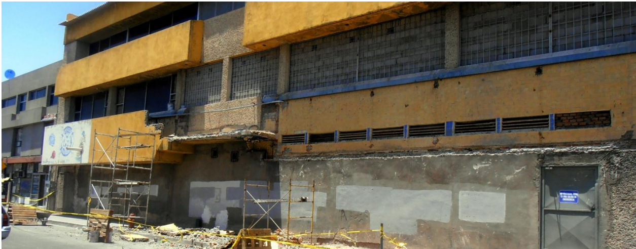
Imagen 95: Unificación de fachadas eliminando elementos de ornamentación de viejas edificaciones. Fuente: propia.
