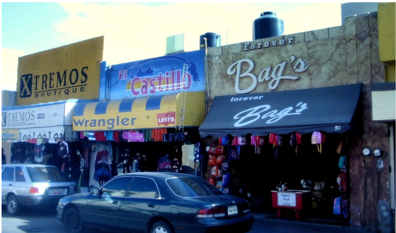
Imagen 25: La variedad de colores, texturas, tamaños y tipologías en fachadas y anuncios, provocan el principal daño visual en el sector centro. Instalaciones eléctricas y dispositivos hidráulicos expuestos Fuente: propia.
