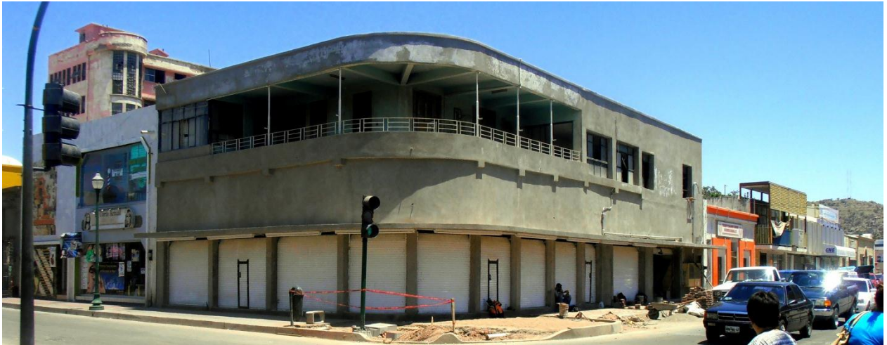
Imagen 92: Resanamiento de vieja edificación en calle Serdán esquina con Juárez. Fuente: propia.
