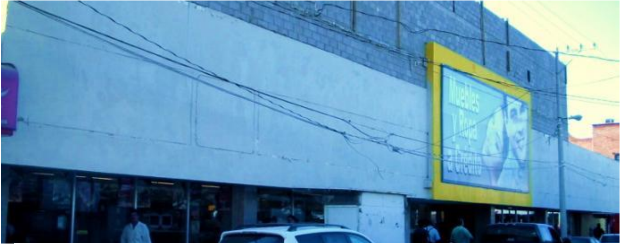
Imagen 75: Tienda Coppel, con fachada no terminada. Fuente: propia.
