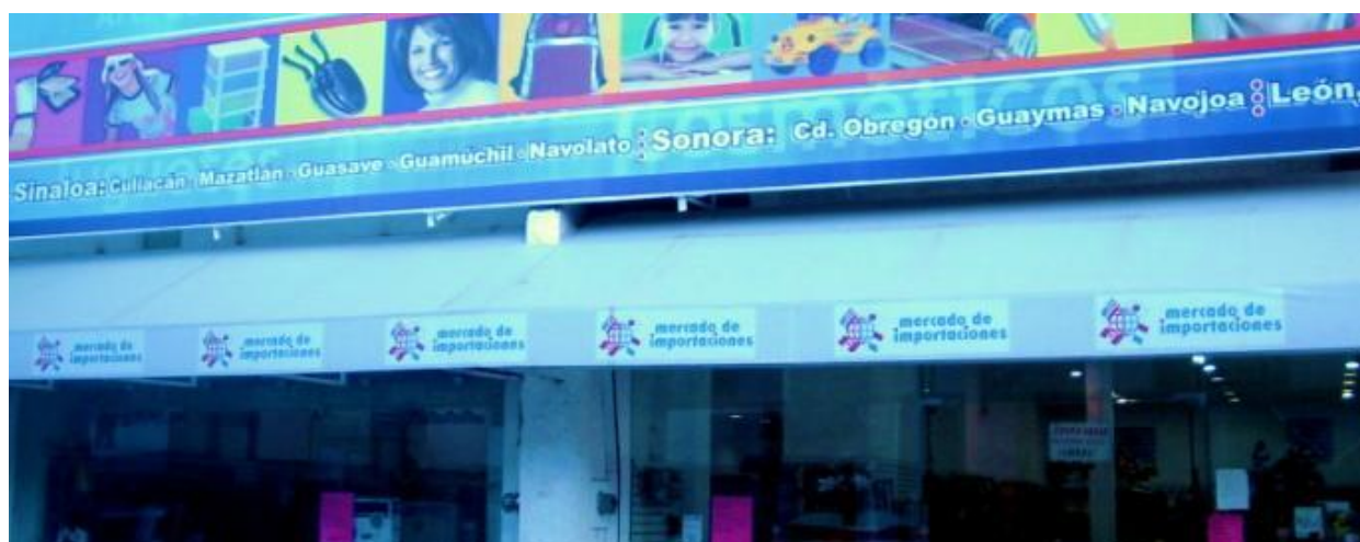
Imagen 68: Anuncios publicitarios integrados al edificio en calle Morelia. Fachada compuesta por vidriera. Fuente: propia.
