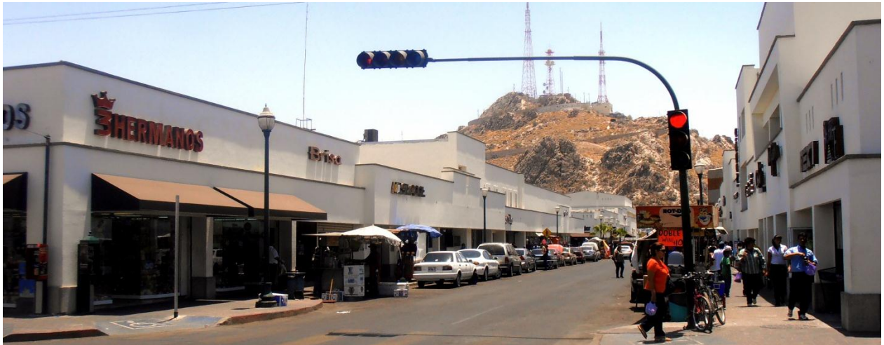
Imagen 86: Calle Matamoros entre Dr. Noriega y Morelia. Colores claros en edificaciones. Fuente: propia.
