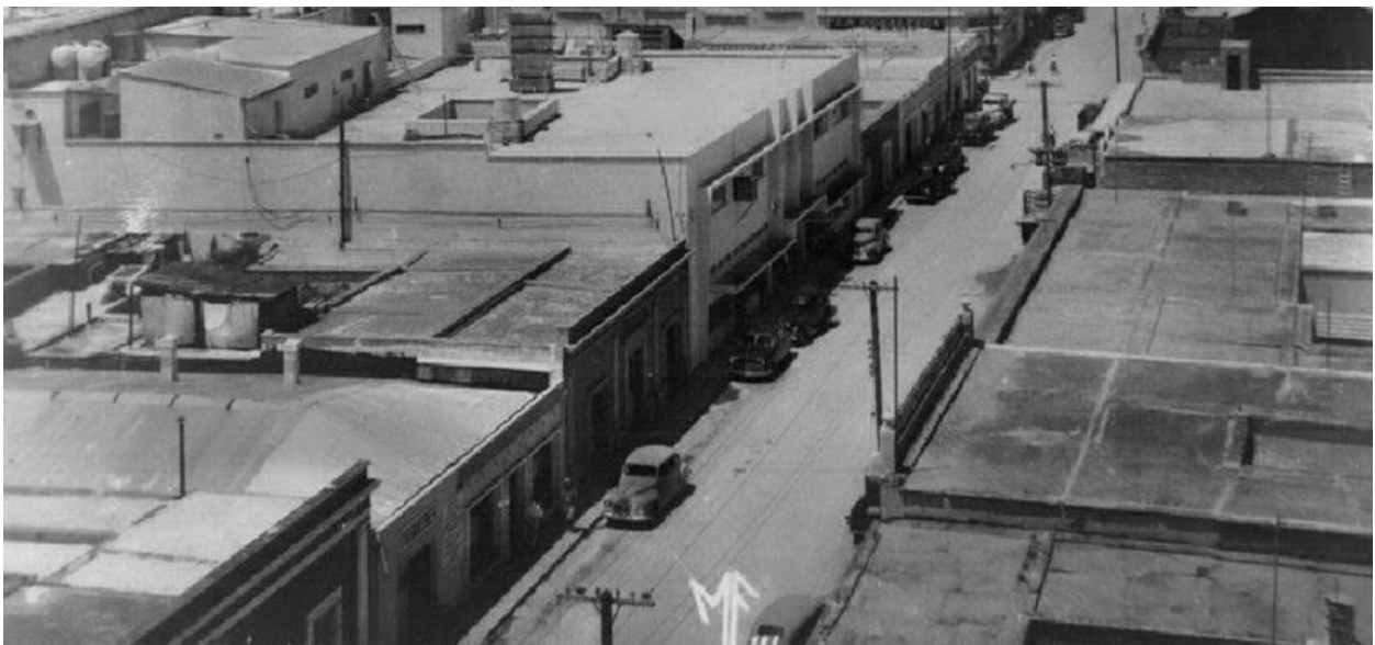
Imagen 2: Hermosillo en 1940. Vista de oriente a poniente por la calle Elías Calles. En la parte derecha se ve el Mercado municipal y en la izquierda el edificio de seguros del pacífico. Fuente: Programa Parcial de Mejoramiento y Conservación del Centro Urbano de Hermosillo. Fuente: http://www.historiadehermosillo.com .
