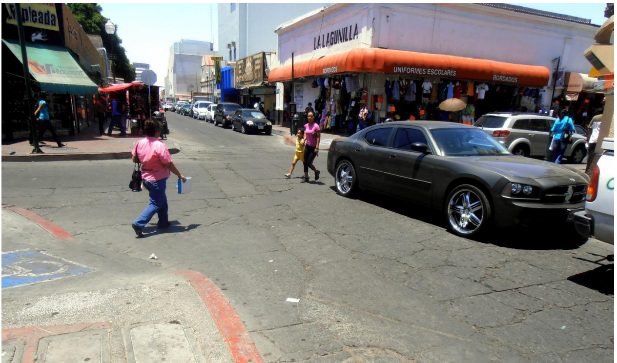
Imagen 21: Indicación de rampa para discapacitados y acotamiento de ancho en vialidades provocado por las esquinas redondeadas. Fotografía tomada entre Vicente Guerrero (horizontal) y Morelia (vertical). Fuente: Propia
