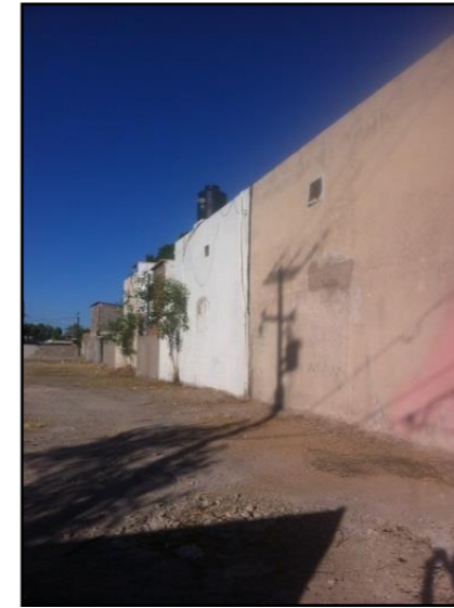
Fotografía 5. Vista de construcciones colindantes desde el terreno. Fuente: Propia
