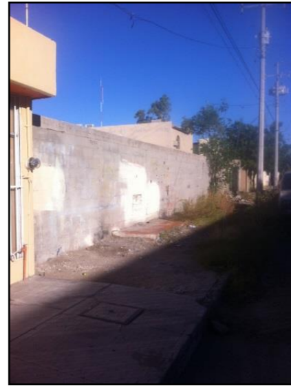
Fotografía 3. Vista de construcciones colindantes, desde el terreno. Fuente: Propia.
