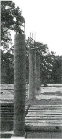
Figura 10. Columna circular recubierta con papel cartón
