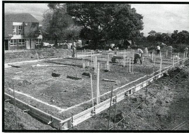
Figura 4. Colocación de cimbra y nivelación de terreno
