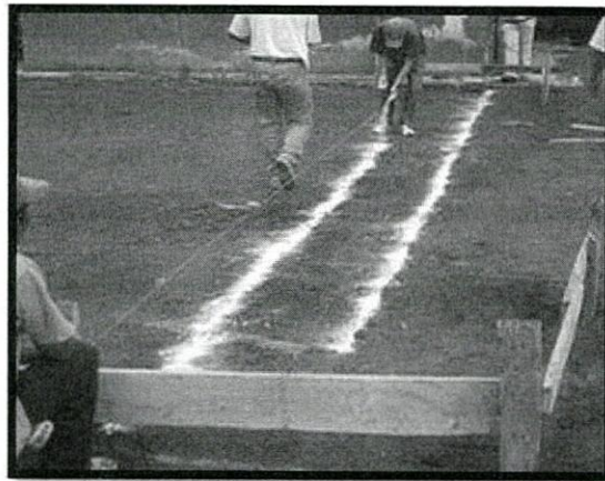
Figura 3. Trazo y nivelación de terreno
