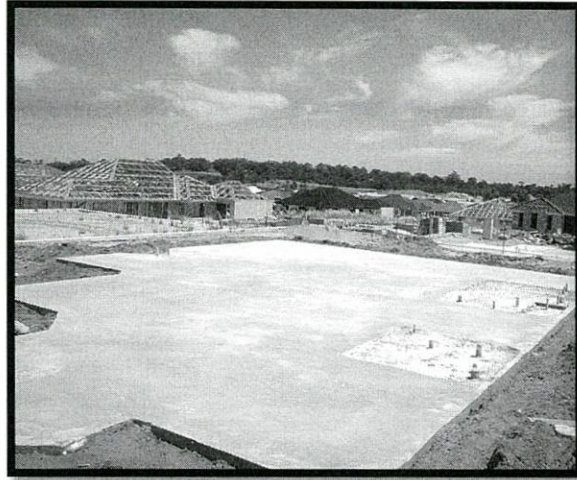
Figura 9. Losa de cimentación
