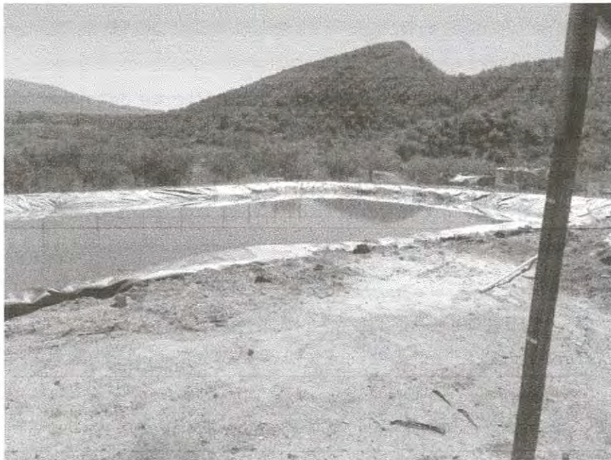
Figura 16. Pileta de emergencia de la mina Virgen del Carmen Fuente: Elaboración propia
