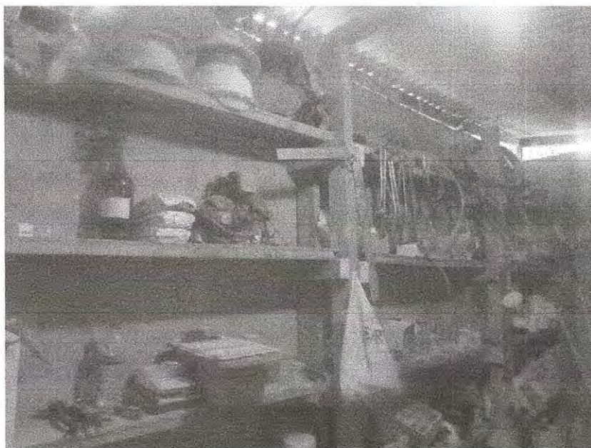
Figura 6. Almacén de materiales.
