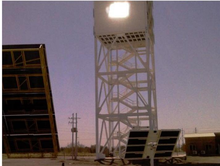
**Figura 2.3.** Sistema de concentración térmica de torre central UNISON
