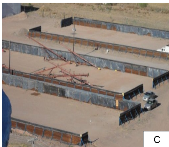
Figura 9. Almacenes de maíz en el estado de Sonora. A- Silos de Concreto en Guaymas; B- Silos de Acero y C- Patios de almacenamiento al aire libre en Navojoa.
