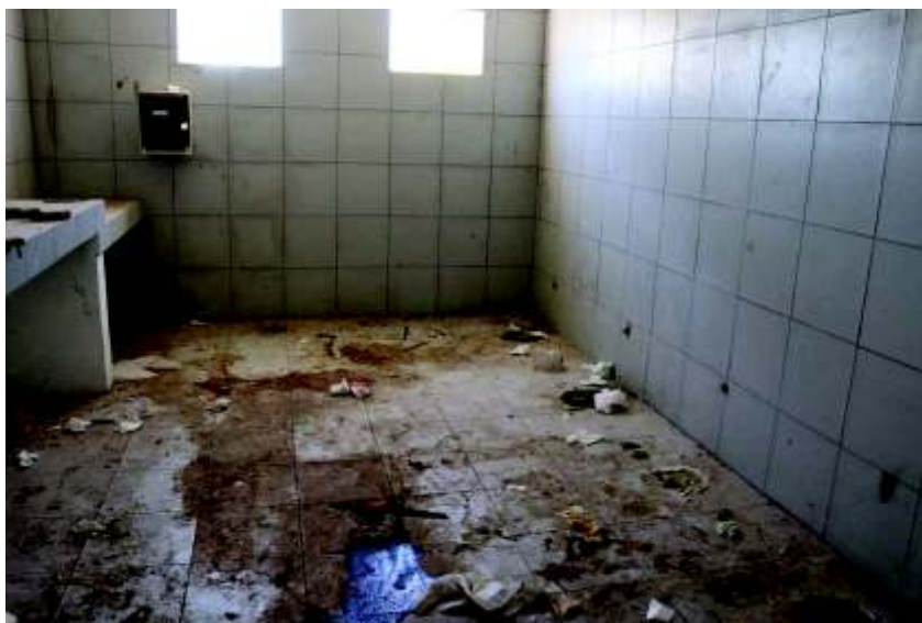
Fotografía 01. Interior Baños. 8 de febrero 2019. Josep Romans Fontacaba
