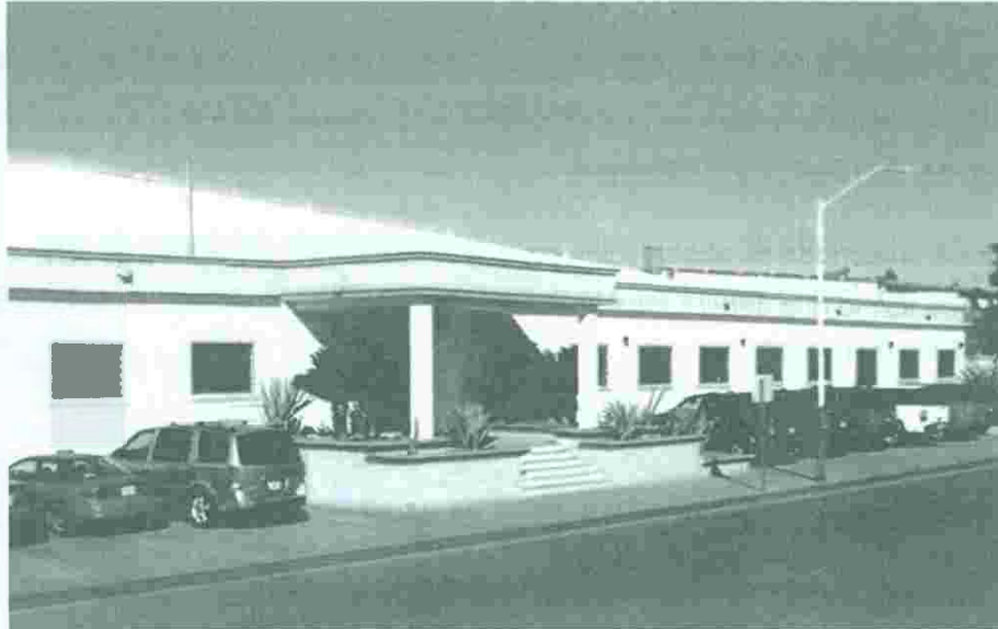
Fotografía 1. TE Connectivity, planta 1
