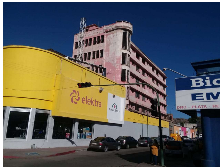
Figura 3.4. Vista del tipo I de construcción
