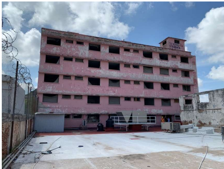
Figura 3.14. Vista lateral del hotel Laval
