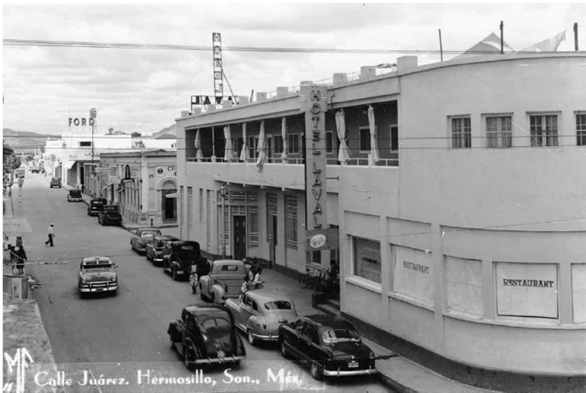
Figura 3.10. Vista hacia el norte de la calle Juárez. Fuente: México Fotográfico
