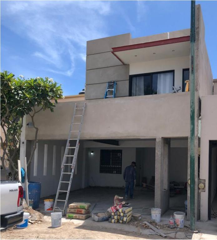
Figura 28 Volado en recámara principal ampliada para protección de incidencia solar
