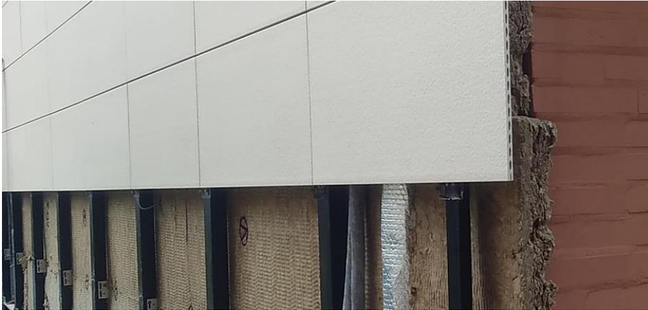
Figura 10 Ejemplo fachada ventilada.
