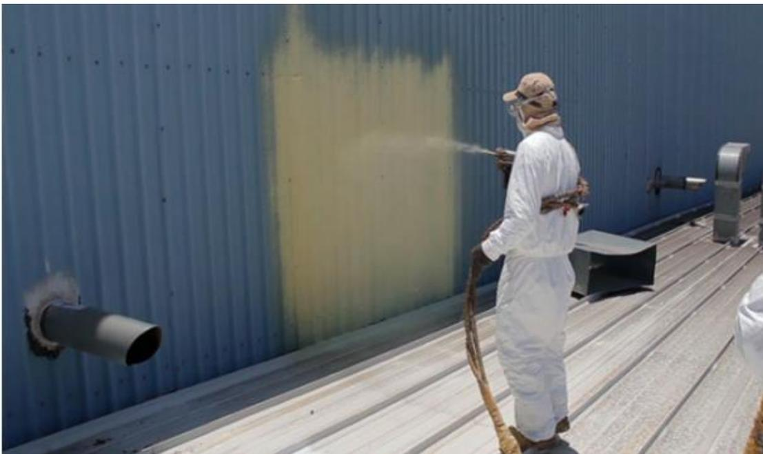
Figura 6 Aplicación de poliuretano esreado en muro como aislante térmico
