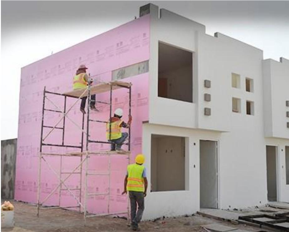
*Figura 8 Aplicación de placa aislante en muro*
