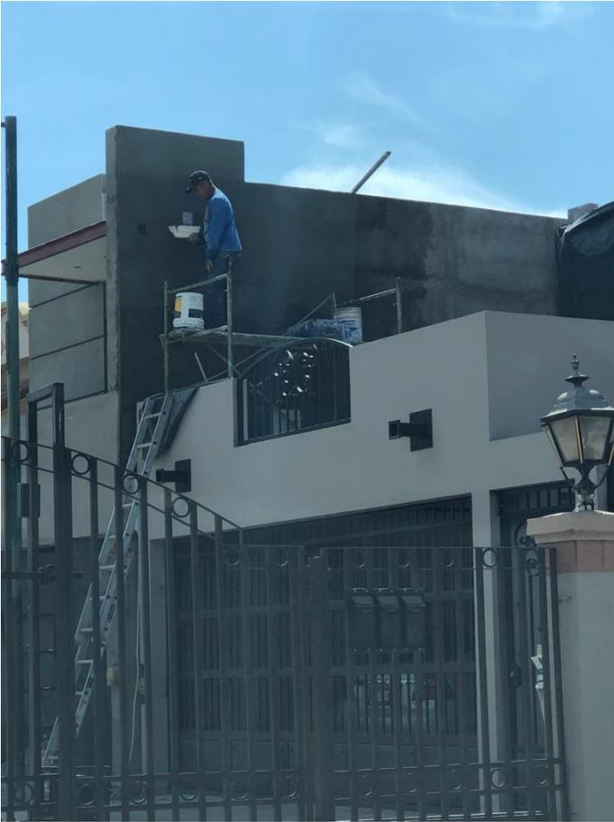
Figura 27 Aplicación de enjarre grueso y fino en muro colindante orientado al Oeste
