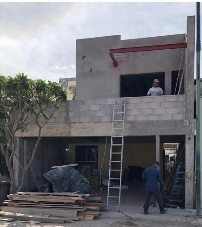
Figura 25 Posición de volado en recamara principal y muro doble de terraza
