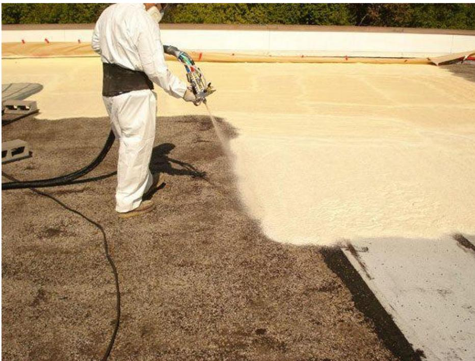
*Figura 9 Aplicación de poliuretano esreado en losa*
