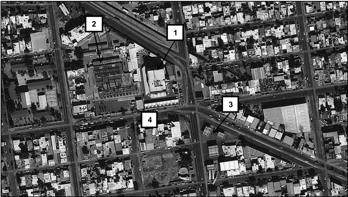
Figura 4.4. Identificación de Riesgos circundantes del Área de Control Noroeste. Google maps (2013).
