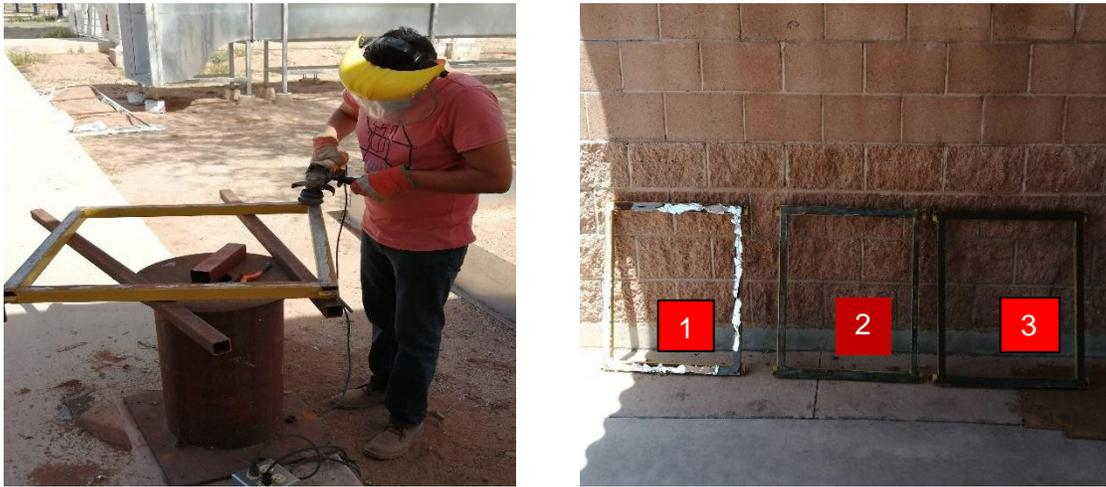
Figura 80. Limpieza de marco (Izquierda) y proceso de limpieza (Derecha)
