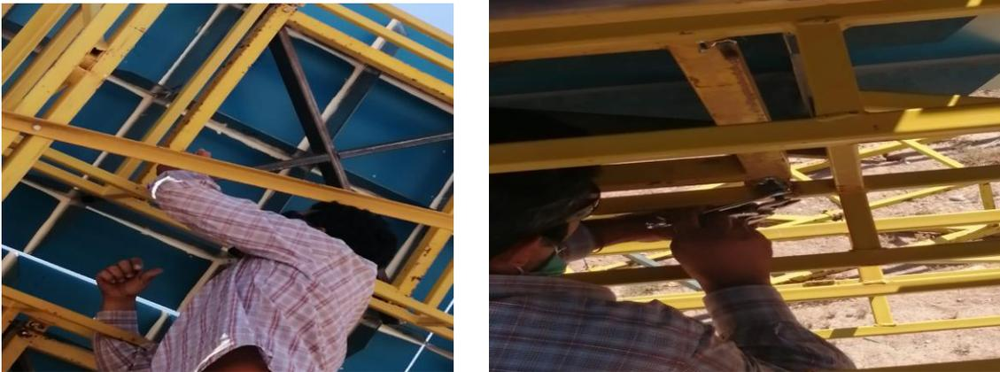
**Figura 89.** Proceso de canteo de facetas del heliostato F0.
