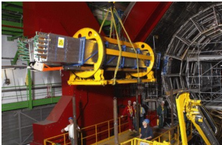
Figura 6 En esta fotografía se mira el momento cuando se esta instalando el TRD
