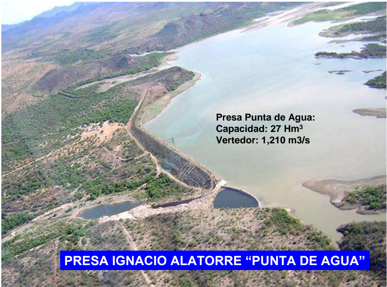
Figura 16.- Vista aérea de la presa Punta de Agua (CONAGUA, 2006)
