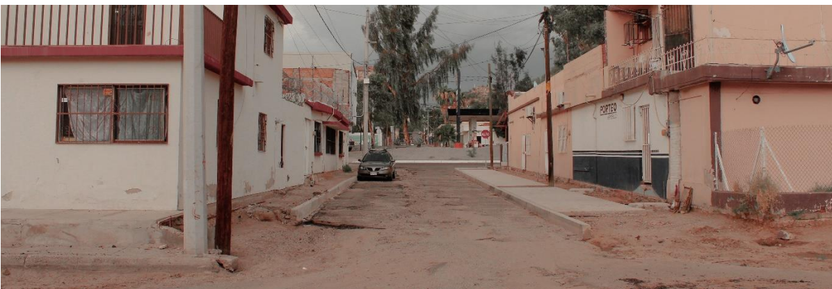
Figura 18 Estado actual de infraestructura banquetas para movilidad peatonal
