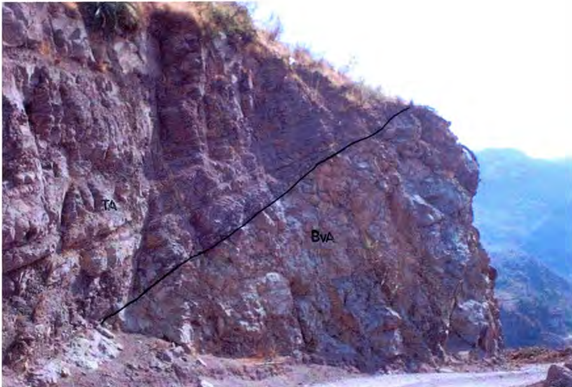
Foto 6.- Detalle del afloramiento de la secuencia volcánica (Tpa e BvA-A), donde se observa una pseudoestratificación bien marcada. Localidad al este de Topia.
