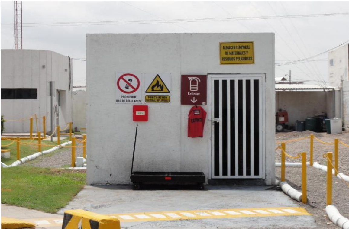
Fotografía 5.- Almacén temporal de materiales y residuos peligrosos.
